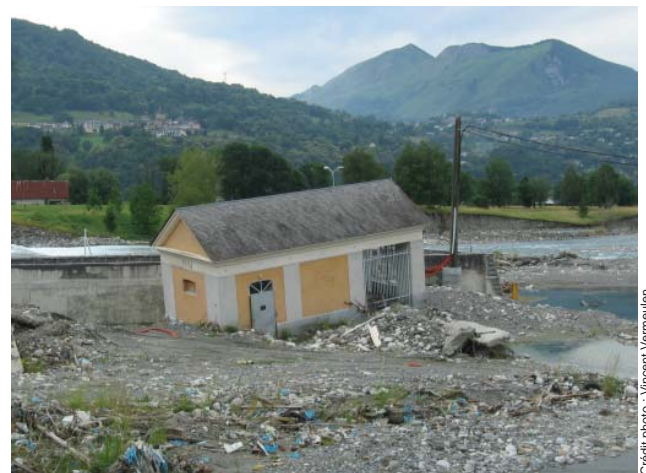
Barrage amont du Lac des Gaves dans les Hautes-Pyrénées suite à la crue de juin 2013
